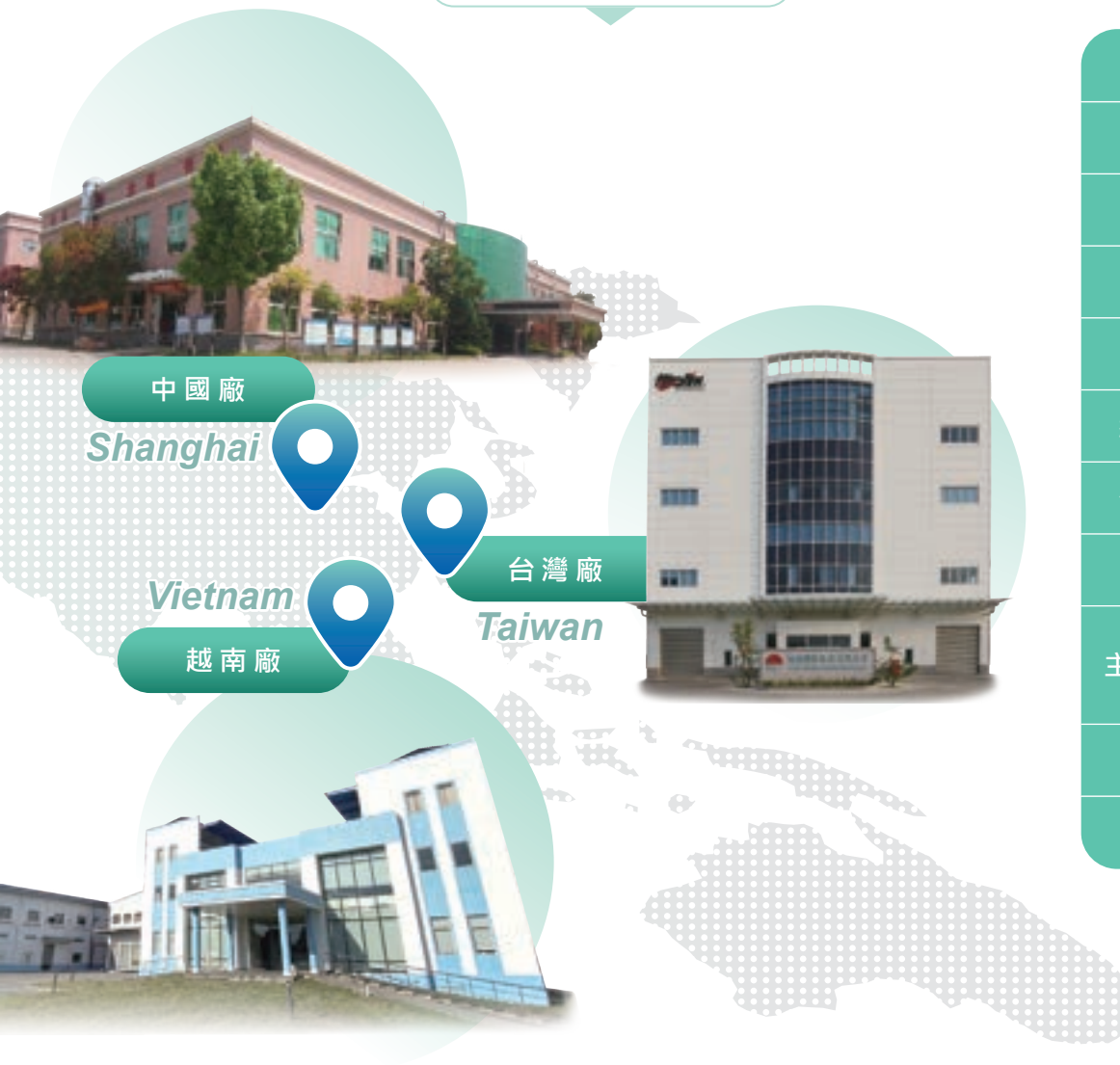
旭然國際廠房照片
